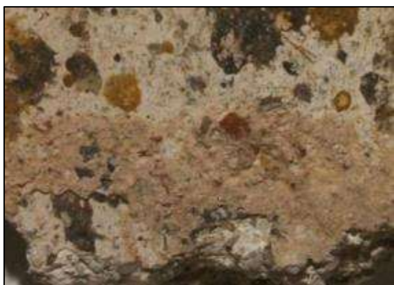
219. kép. Terrazzo habarcsa a már festett vakolatra kötve. ( Savaria, Iseum korai falfestménye, lábazat. Foto: H.E.–K.Zs.)
