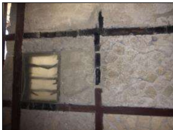
21. kép. Faszerkezetes falazat. Casa dei Due Atri, Herculaneum. (Foto: H.E.)
