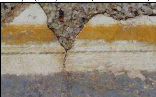
222/d. kép. Zsinórlenymatba beült kék festék. (Foto: H.E.–K.Zs.)
