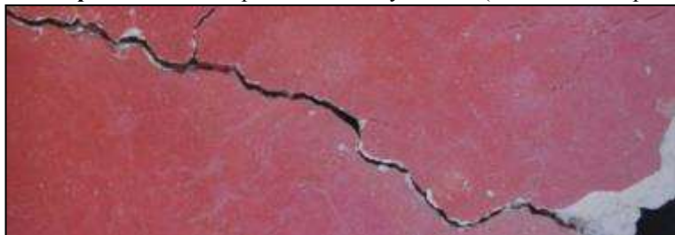
273/a. kép. A vörös felületen megfigyelhető repedések (Foto:H.E.–K.Zs.) 273/b. kép. Befolyt festék. (Foto:H.E.–K.Zs.)
