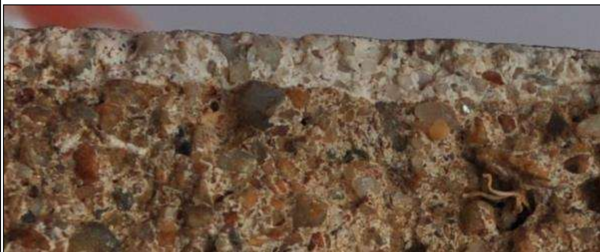
69/a. kép. Intonaco vastagsága 2,5-3 mm.
