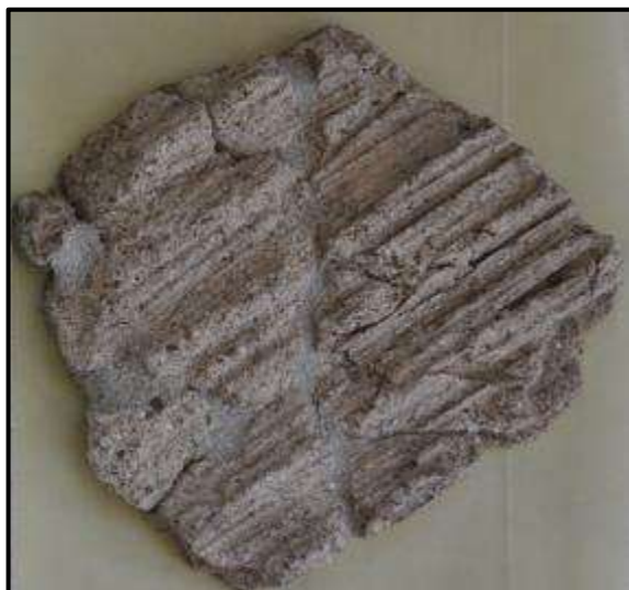
47/b. kép. Kákakötegek lenyomata a hátoldalon. (Foto: H.E.–K.Zs.)
