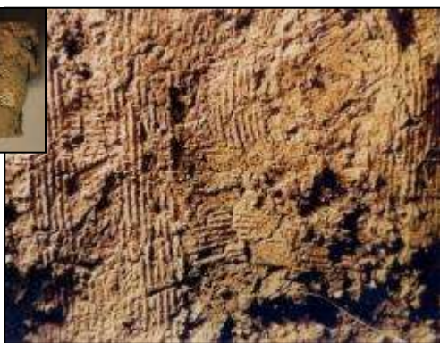
37. kép. Kétrétegű sárvakolat első rétegébe húzott kanyargós vonalak. Brigetio , K/Sz–Vt. III. peristylum . (Foto: H.E.–K.Zs.)
