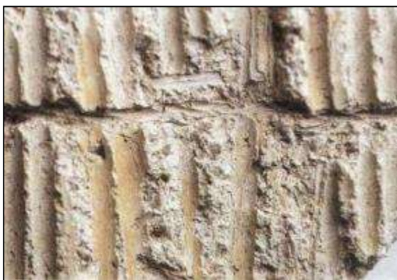
25. kép. Nád és a kötözésére használt spárga lenyomata. Villa..., Campagna. (Wallert-Elston 1996, Plate Ic)
