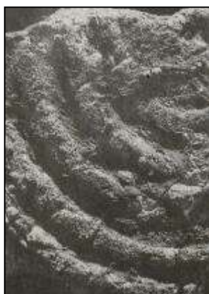
42. kép. Sárvakolatba pecsételt vagy hengerelt minta lenyomata. (Vicus 1. Ács–Vaspuszta. Járó 1991, Fig. 1/4. Foto: Rosta J.)
