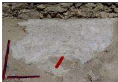
246/b. kép. A hátoldal leragasztása Paraloid B 72 acetonos oldatával, hurkapálcákkal merevítve.
