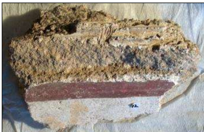
218. kép. A könnyűszerkezetes mennyezet vakolása után készült az oldalfalak vakolása. A mennyezet vakolatában a könnyűszerkezet lenyomata látható. ( Savaria , Iseum korai falfestményei. „kandeláber fríz”. Foto: H.E.–K.Zs.)
