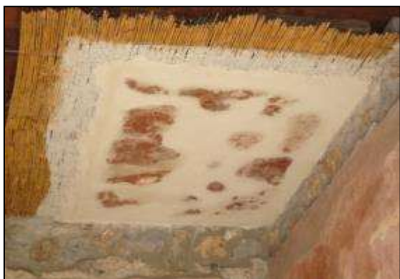
24. kép. Rekonstruált nád stukatúr mennyezeten. Casa del Menandro, Pompeii (Foto: H.E.)
