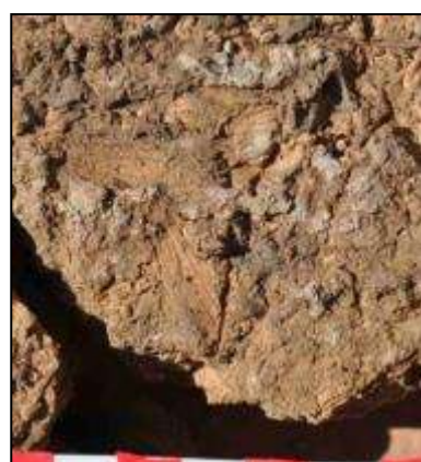
43. kép. A sárvakolat rűskös felülete és a sárvakolatba kevert növényi rostok lenyomata. (Szöny/Dunapart – 1-es lelőhely, Fürdő, Brigetio . 2014. Foto: H.E.)
