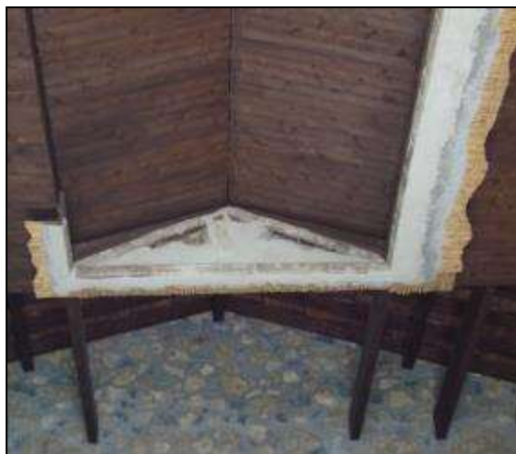
23. kép. Rekonstruált nád stukatúr mennyezeten. Casa del Menandro, Pompeii (Foto: H.E.)
