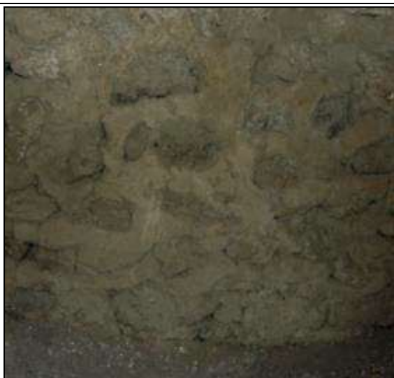
18. kép. Kőből épített falazatra felhordott kiegyenlítő sárhabarc (Pompeii Reg. IX, Insula XII. Foto: H.E.)
