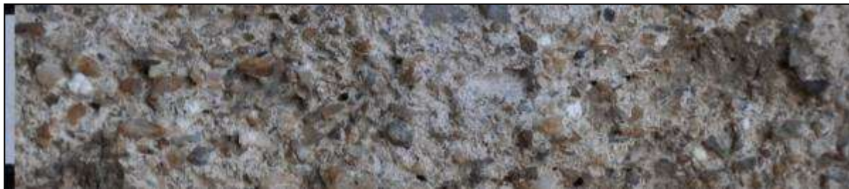
11. kép. Folyami homokkal készült vakolatréteg. Töredék Savaria, korai Iseum falfestmény leletéből. (Foto: H.E.)
