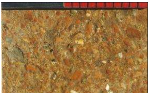
220/a. kép. Terrazzo padló. (Foto: H.E.–K.Zs.)
