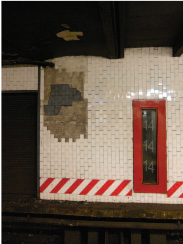
3 | 14 th Street – Union Square metróállomás – fotó: Korodi János
