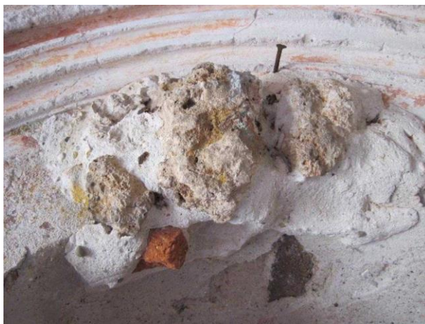
40. kép. A fülkéket keretező kő- és sziklaberakások
