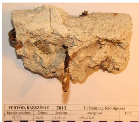
141. kép. Vakolat hordozóhoz való rögzítésére alkalmazott szegek
