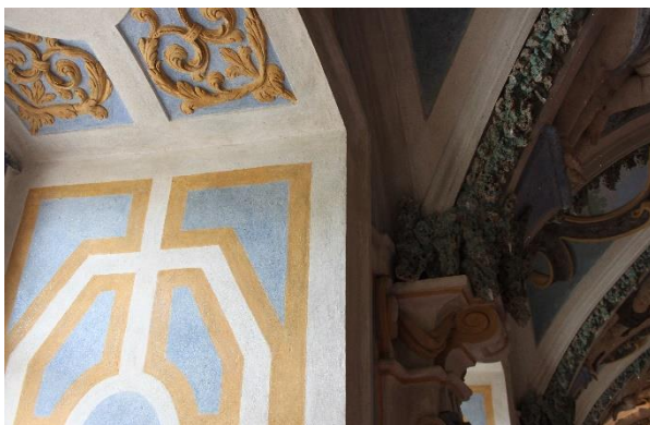
220. kép. Az ablakfülkék díszítése
