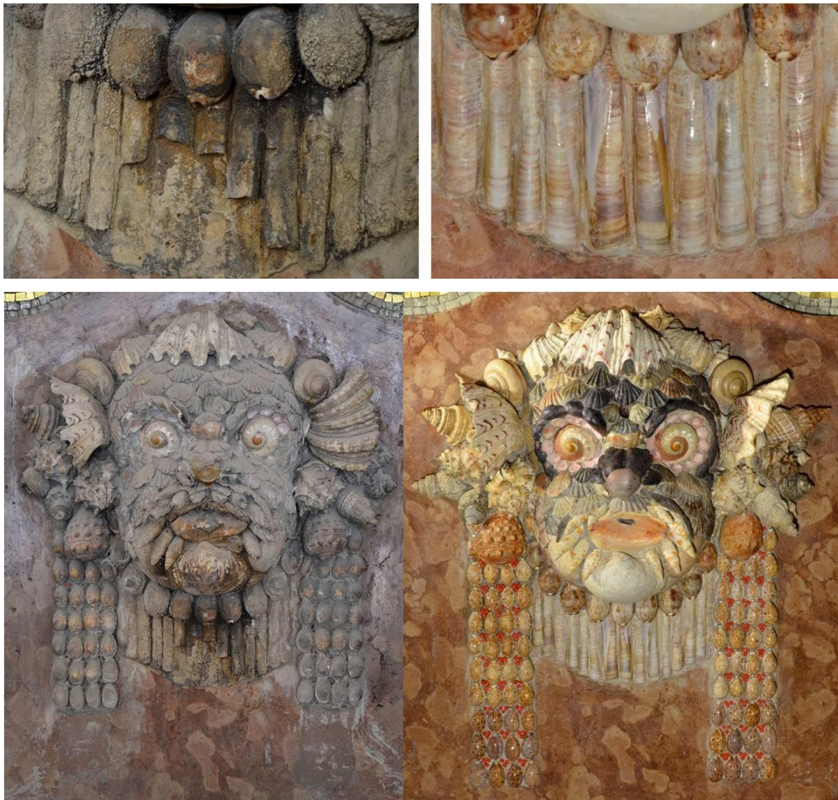
235-237. kép. A csigákból, kagylókból kirakott vízköpő fej restaurálás előtt és után
